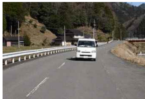
二車線の広い道
