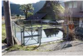
↑東西に流れる防火水路 北集落内に複数ある防火水槽↓
