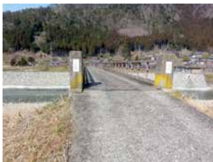
↑北集落と南集落を結ぶ長除橋（赤橋）
