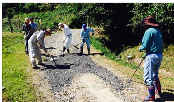
▼農道補修作業
